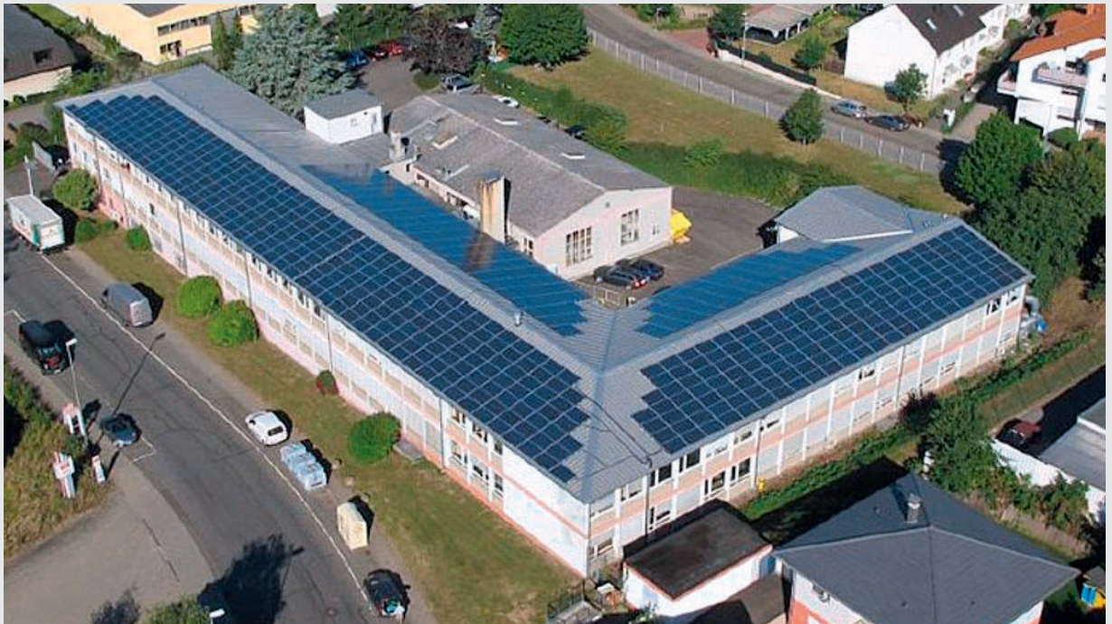
Blick von oben auf das Firmengebäude im Ostring – die Photovoltaik-Anlage wurde 2011/2012 installiert
